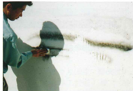
落書き除去 開始(専用除去液を使用)
